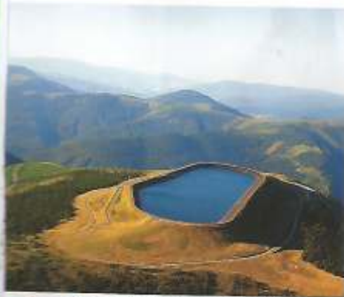
• hlavní nádrž záložní elektrárny Dlouhá Stráň
