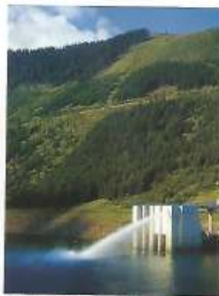
• betonový objekt dolní nádrže
